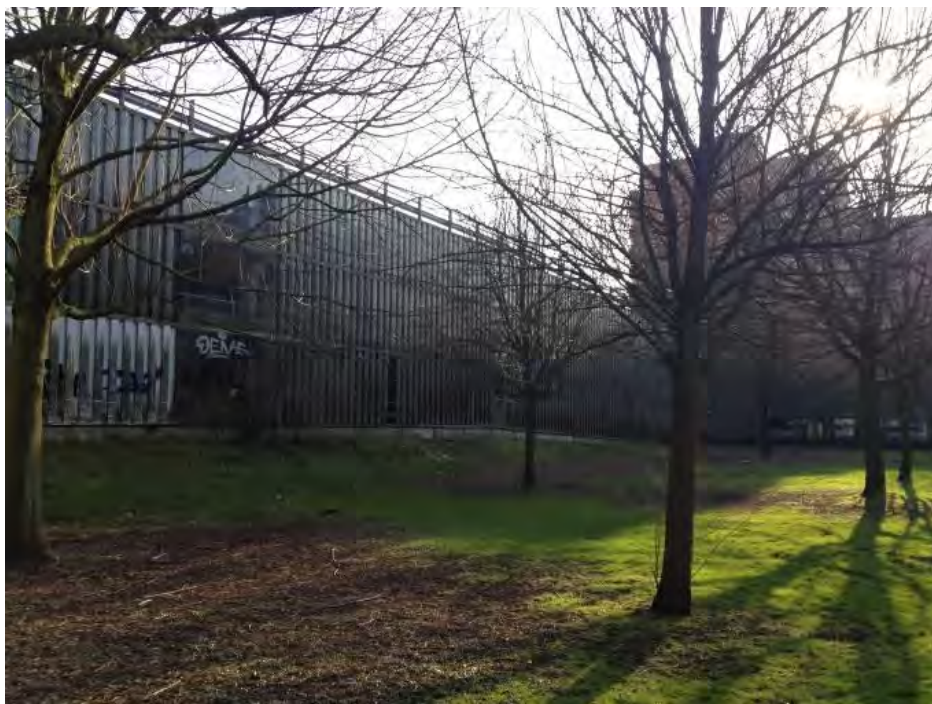
Eén van de parkeergarages binnen het plangebied
