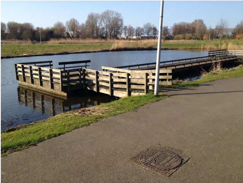
Bestaand oppervlaktewater binnen het plangebied
